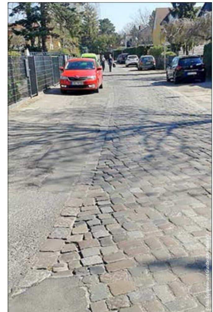
Derzeit nur provisorisch ausgebauter Straße
