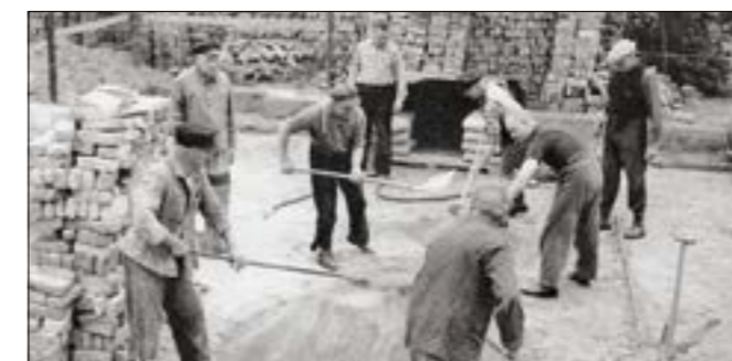
Unter der Leitung des Kollegen Kumm erfolgten die Arbeiten
