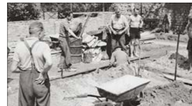
Ausschachtungs- und Betonarbeiten
